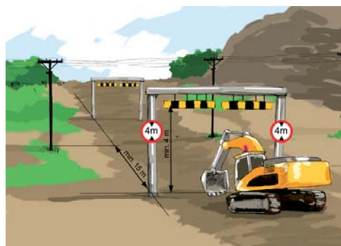
Rys. 4 Prace w bezpośrednim sąsiedztwie napowietrznych linii energetycznych
